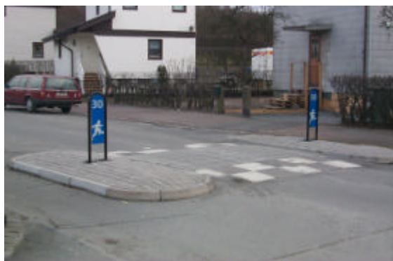
Standardgupp på Utmarksgatan (1 m ramp, skärmar på båda sidorna)
